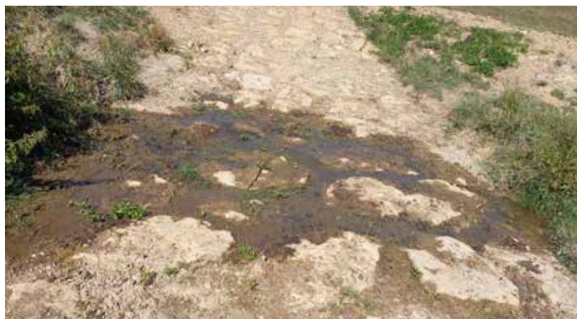
Die Fuhr soll sowohl die Durchgängigkeit des Bachlaufes als auch einen sauberen Übergang für die Tiere und den Landwirt garantieren. Sedimente lagern sich in den Fugen ab.
