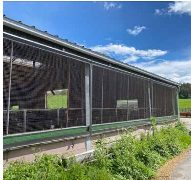
Nach dem Entfernen der Betonelemente wurden Wind- und Vogelschutznetze installiert
