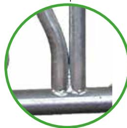
Doppelrohr dreifach verschweißt
